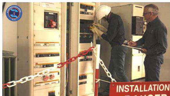
3) Mise en situation du stagiaire pour consigner une arrivée HTA pour effectuer des travaux dans une cellule de protection transformateur par fusible et accéder au transformateur. Application des procédures de travail.
